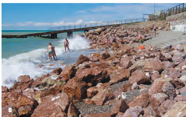
Рис. 6. Эволюция пляжа в центральной части Николаевки после строительства бун: а — 2006 г.; б — 2007 г.; в — 2015 г.
