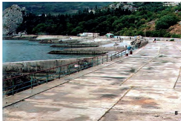
Рис. 1. Схема типичной буны: а) продольный разрез; б) поперечный разрез; в) типичная схема берегозащиты на ЮБК с системой бун (Артек)
