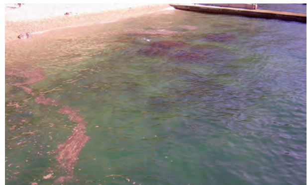
Рис. 4. Результат застойных явлений в межбунных пространствах
