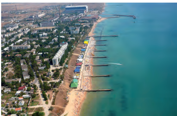
Рис. 4. Общий вид берегозащитных сооружений п. Приморский
