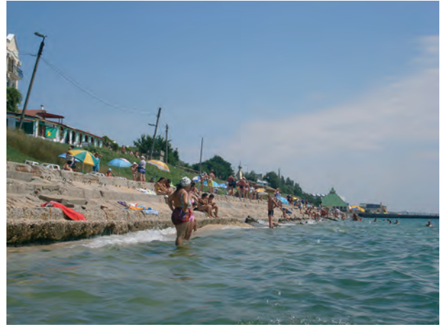
Рис. 5. Вид береговой линии с откосными сооружениями в п. Приморский
