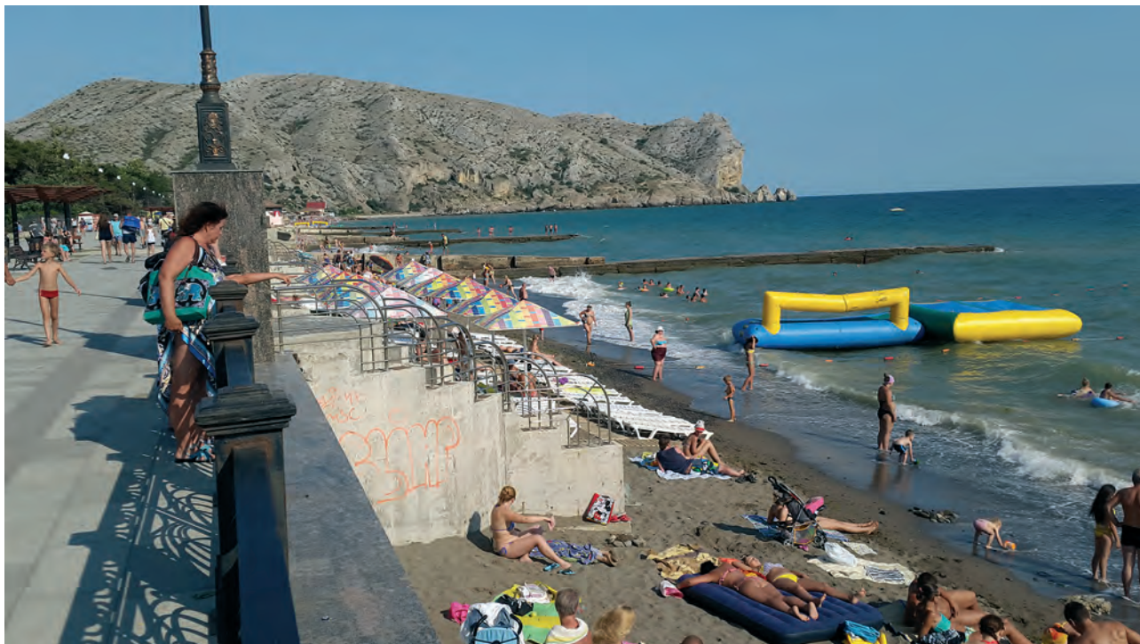
Рис. 7. пляж и берегозащитные сооружения в г. Судак
